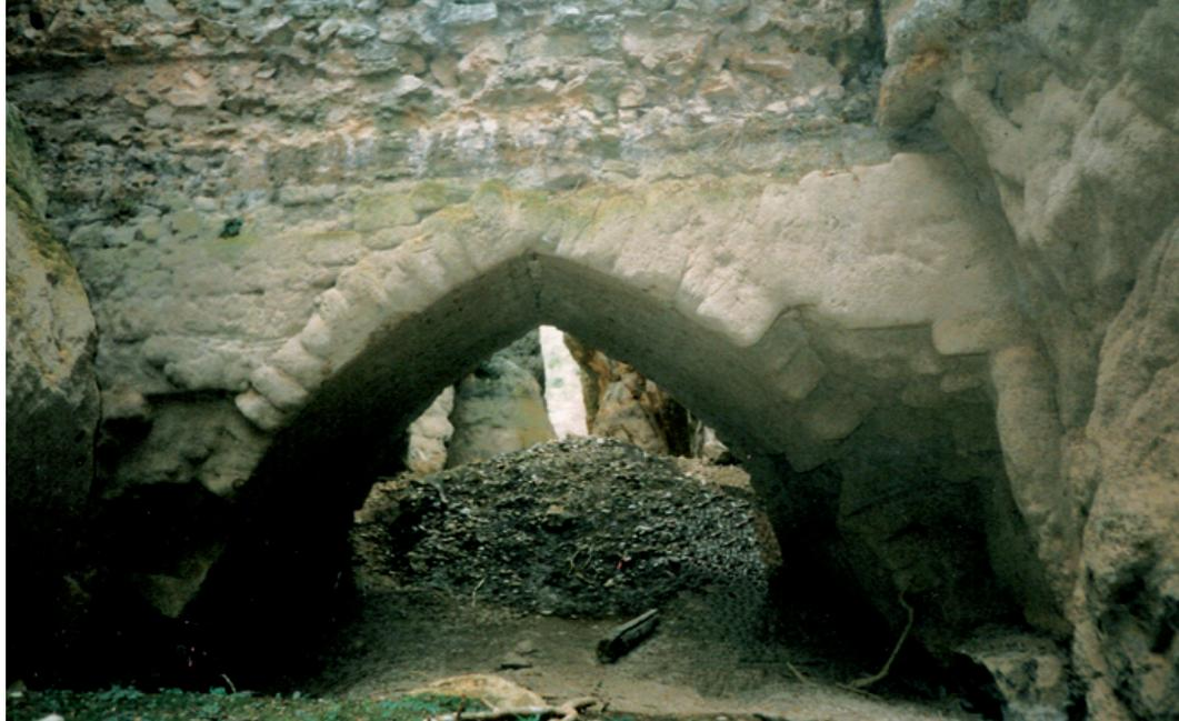
Sedimentos aguas abajo del Arquillo. Se aprecia el deterioro de los laterales del Arquillo debido a los golpes de los diversos materiales al entrar en él. (Fotografía cedida por M.C. Maicas Gómez).
