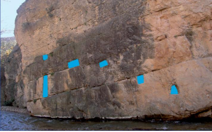
Pintadas de azul las marcas de anclajes para maderos en la construcción del azud.
