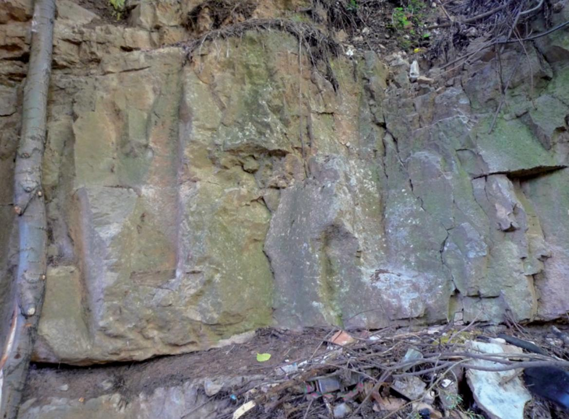
Evidencia de la existencia de anclajes picados en la roca para sujeción de troncos en la construcción de un azud. Al lado derecho de la base del actual puente en el cauce del río.
