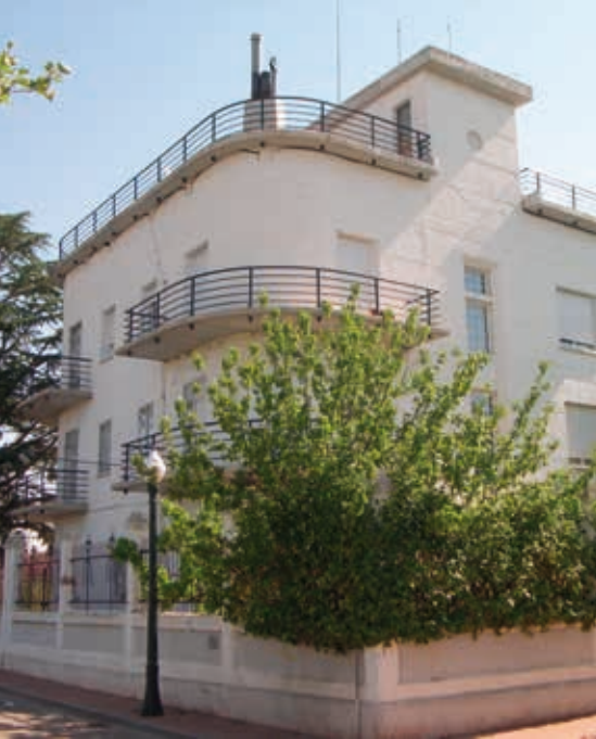
Fig. 5. Vista actual de la Casa del Barco en la calle San Fernando nº 24 de Teruel proyectada por Juan José Gómez Cordobés (1934).
